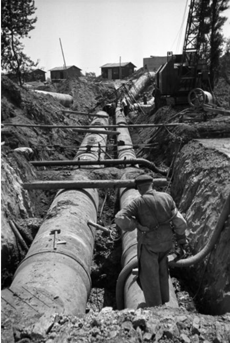
Abb. 23: Bau von Abwasserkanälen in Essen, 1951
